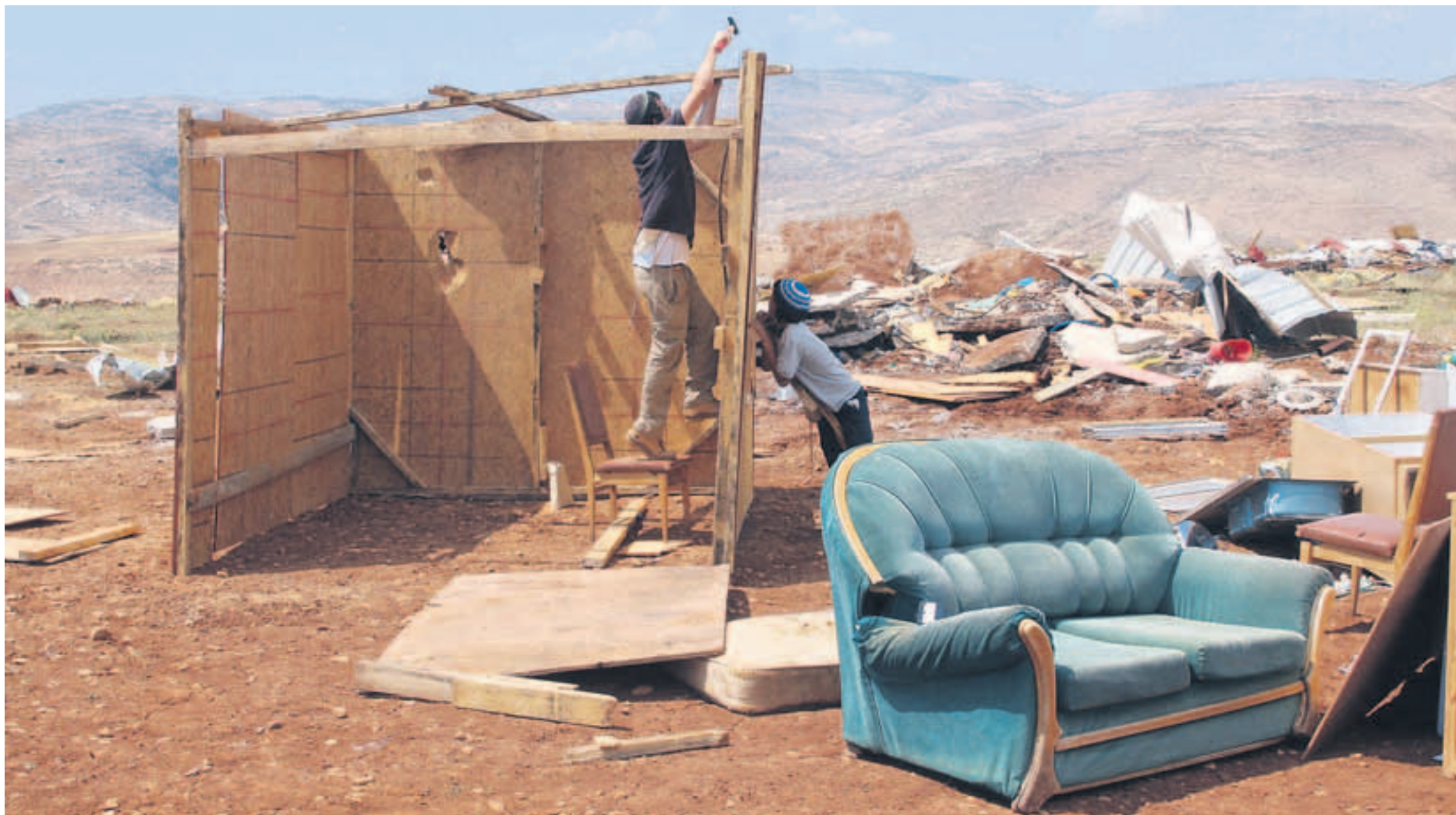
Aus dem Boden gestampft. Der Baustopp im Westjordanland gilt noch bis zum 26. September. Trotzdem werden überall israelische Siedlungen errichtet.
